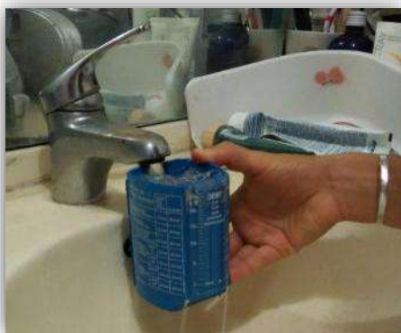
Vérification des débits des points de puisage
