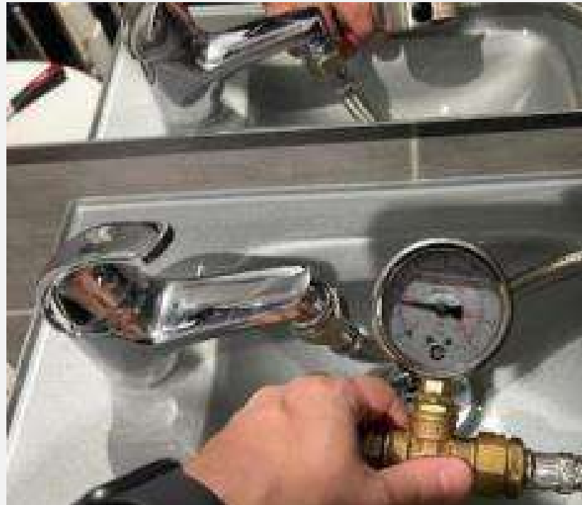
Mise en pression
