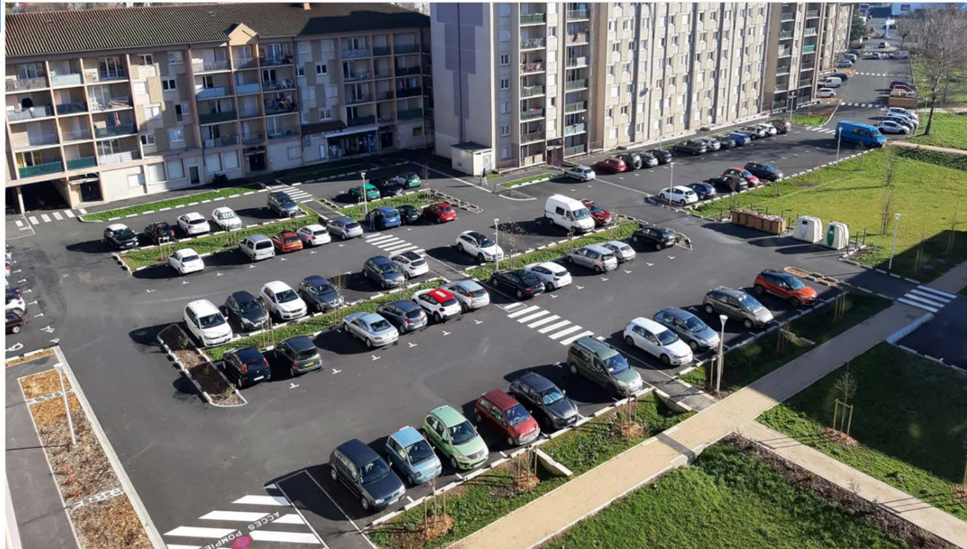
Vue d'ensemble de la Cité de la Montade après travaux (Crédit : Cantal Habitat)
